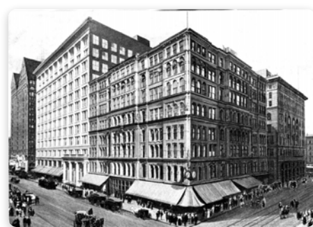
L'immeuble Beaux-Arts de treize étages de Daniel Burnham, à l'angle des rues State et Washington,
