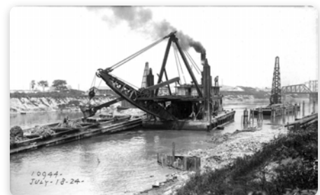
Dragage d'un batardeau sur le Sanitary and Ship Canal, à hauteur de Cicero Avenue, 1924.
