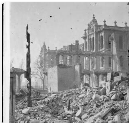
Ruines du palais de justice et de l'hôtel de ville après l'incendie de 1871.
