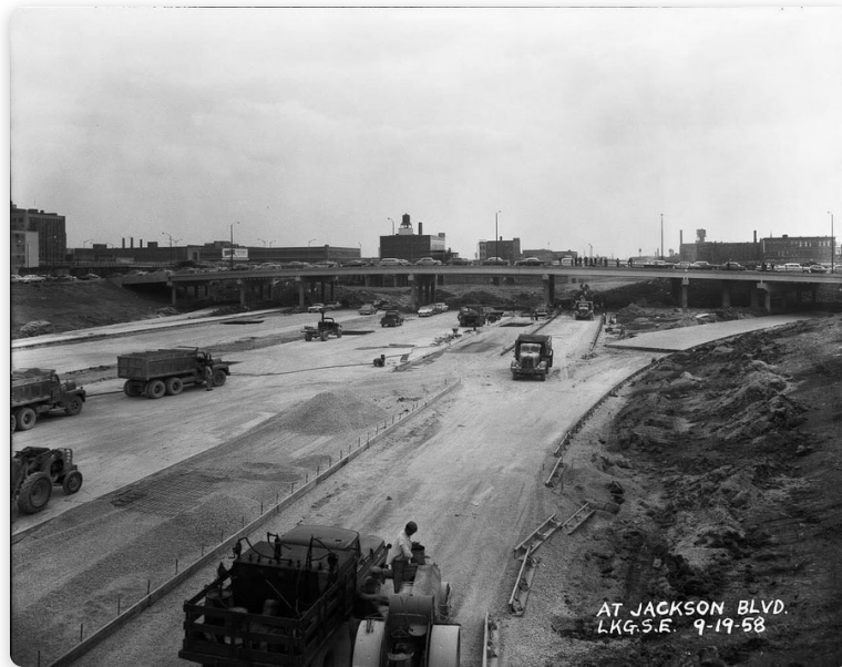
Le Kennedy Expressway à Jackson Boulevard, en construction, 1958.
